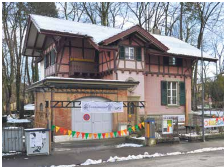
Haus mit bewegter Geschichte: Die Sulgenbachstrasse 5a.
