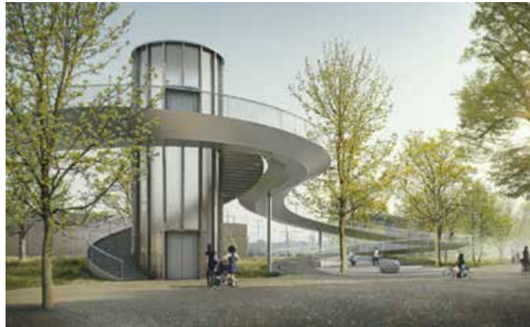
Der Zugang von der Bahnstrasse (Bild: Fürst Laffranchi Bauingenieure GmbH)
