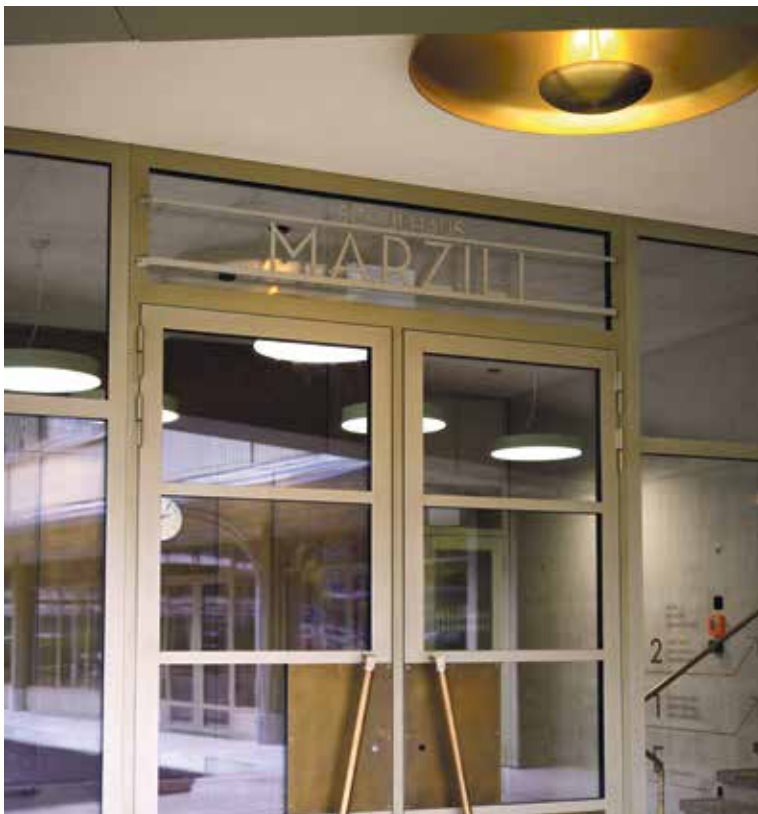
Die Marzili-Schule platzt dank der Erweiterung nicht mehr aus allen Nähten.
